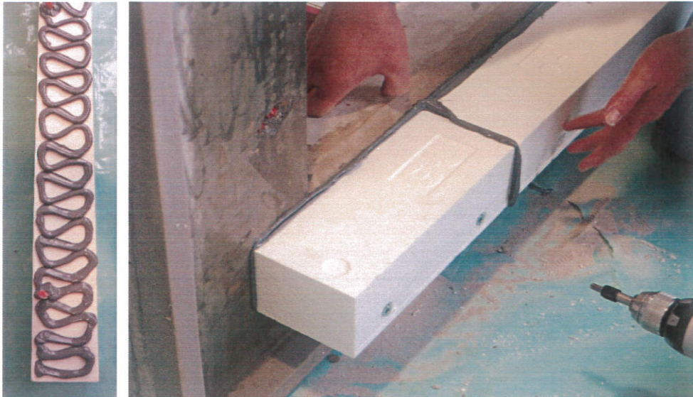
Links: Aufbringen des GU-1K Montagekleber Rechts: Montage der GU-Vorwandzarge
