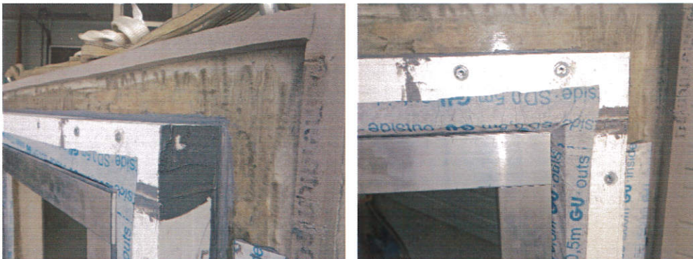
Links: Fertiggestellter oberer Anschluss der GU-Vorwandzarge Rechts: Fertiggestellter äußerer oberer Anschluss des Fensters
